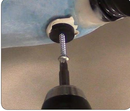
2. En la ubicación seleccionada en el paso anterior, perforo un orificio de 7,1 mm (*9/32 de pulg.*) que tenga una profundidad suficiente para poder colocar el taco. Limpie los bordes del orificio.
