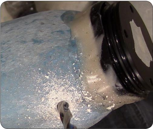
3. Inserte el taco en el orificio.
